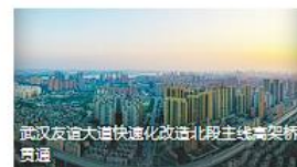
武汉友谊大道快速化改造北段主线高架桥贯通
