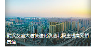
武汉友谊大道快速化改造北段主线高架桥贯通
